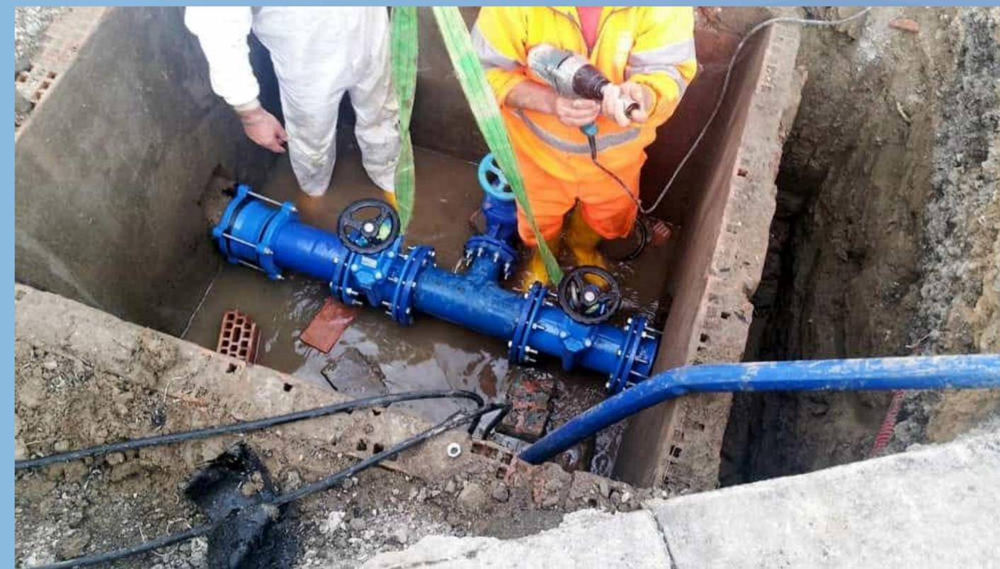
**Misura 5: INTERVENTI DI MANUTENZIONE STRAORDINARIA PER LA RIFUNZIONALIZZAZIONE DI CONDOTTE IDRICHE VETUSTE E DI NUOVE REALIZZAZIONI PER OTTIMIZZAZIONE DELLE PERFORMANCE DI RETE.**
